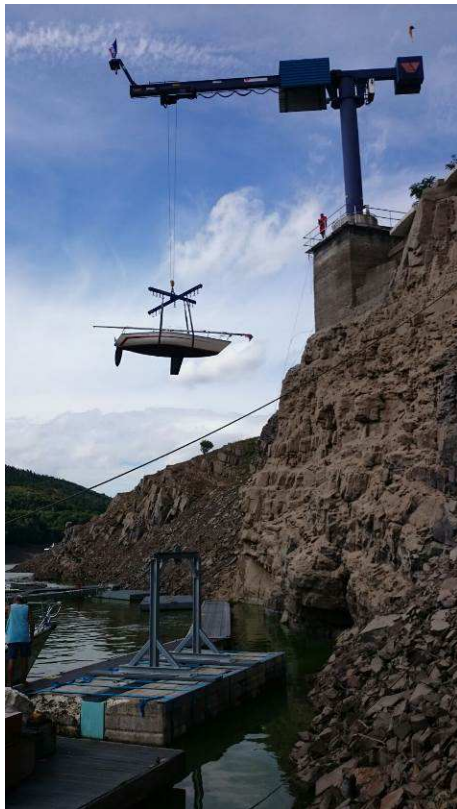
auskranen in Rehbach
