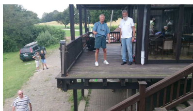
Bauarbeiten am SGK-Clubhaus im vergangenen Sommer: Terrassenrenovierung mit viel Einsatz
